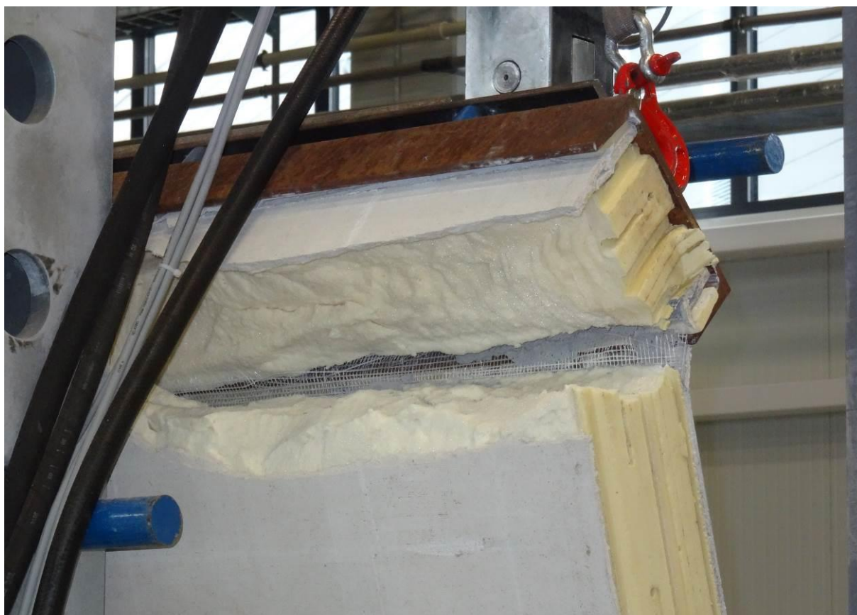
Obr. 24 Detail porušení v horní části vzorku 4.
