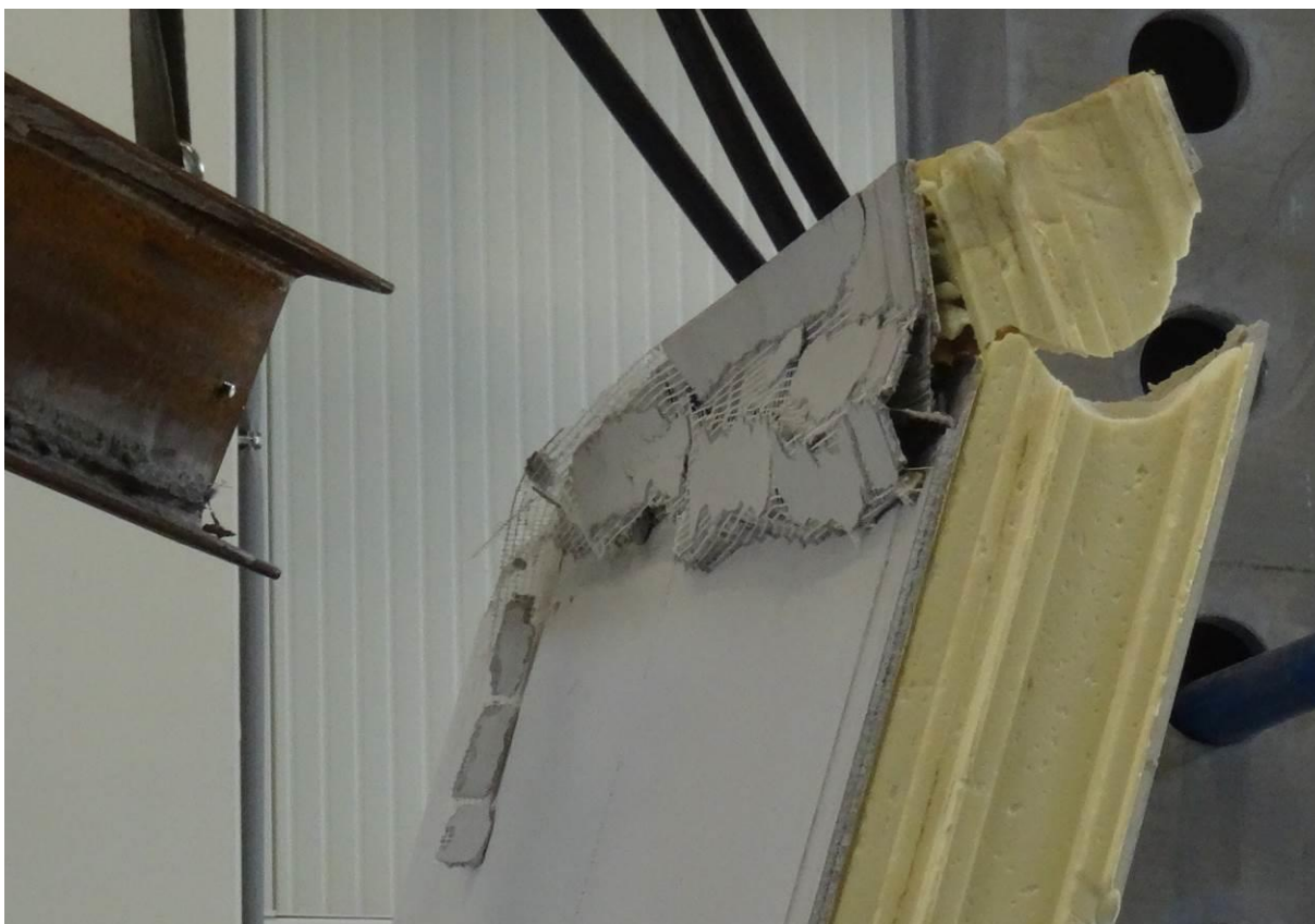
Obr. 15 Detail porušení smykem vzorku 2 po skončení testu.
