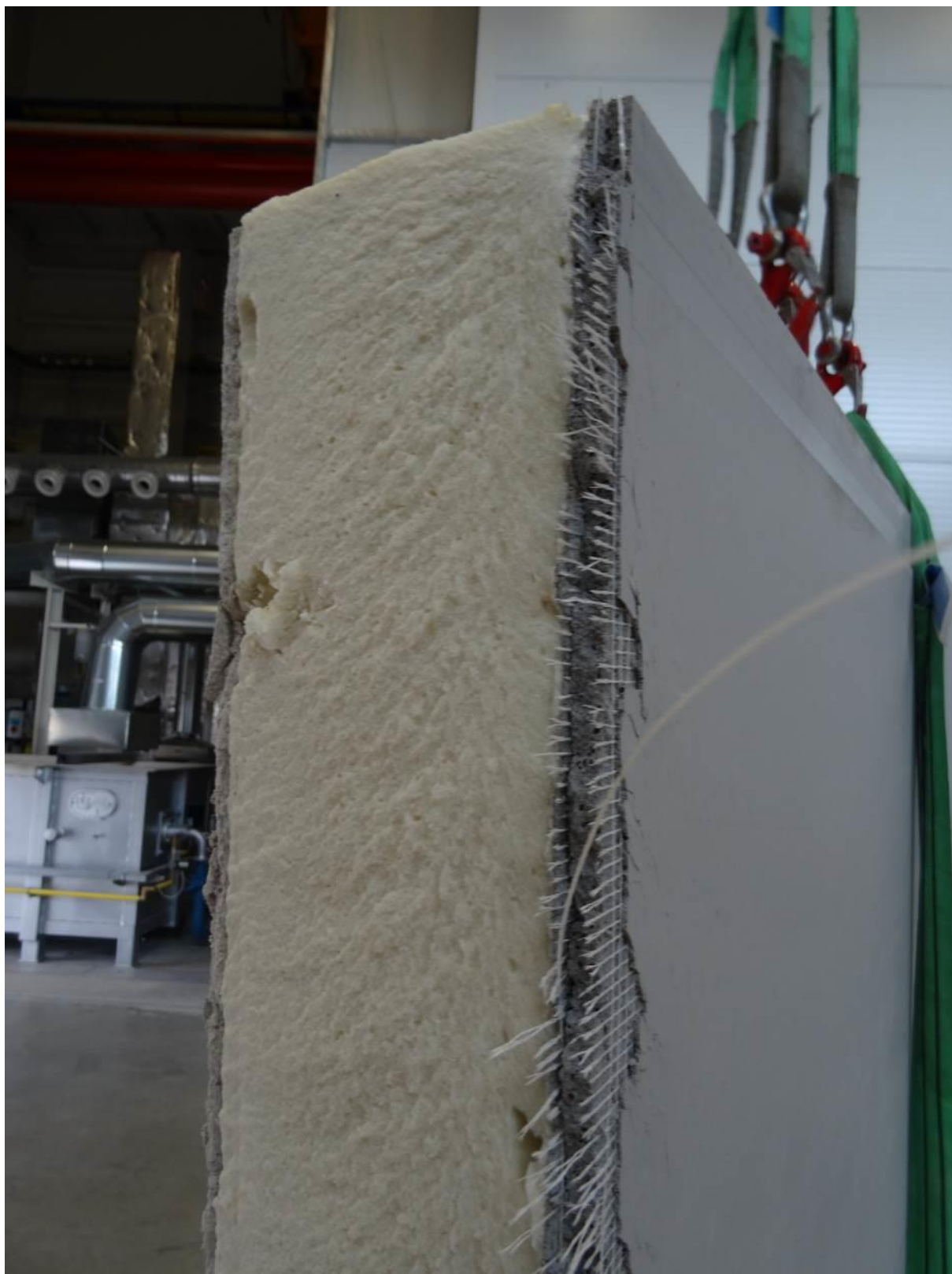
Obr. 9 Vzorek 1 poškozený celoplošným zatěžováním – detail plochy poškození.
